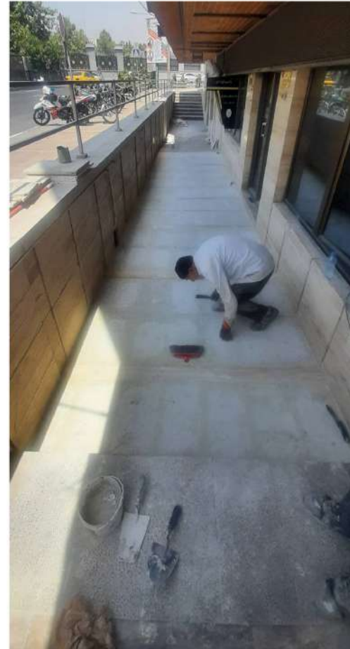
زیباسازی و بازسازی پیاده راه بنیاد فرهنگی رفاه
